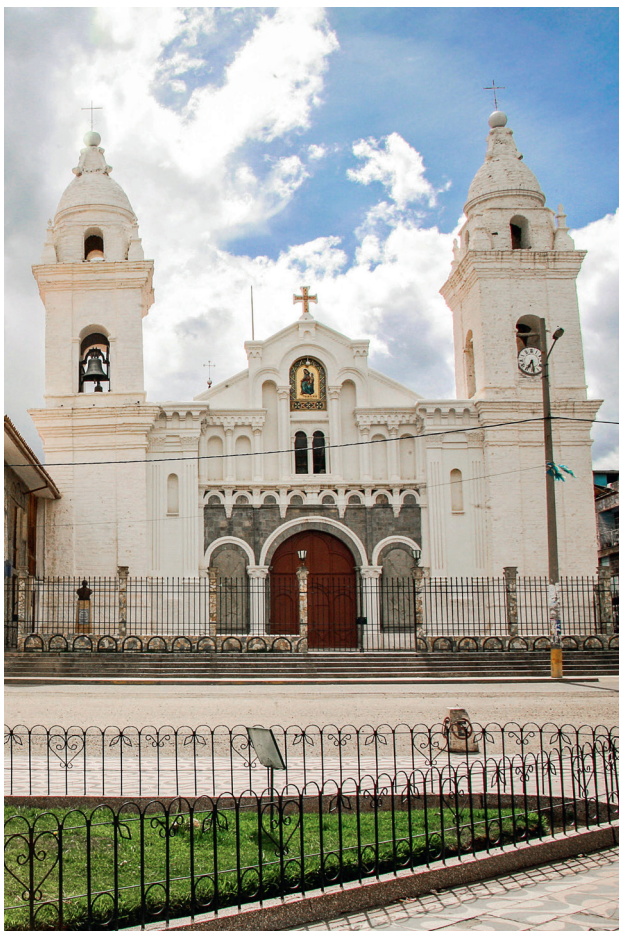
IMAGEN 11. Imagen de la fachada de la iglesia luego de la intervención del proyecto Jauja Monumental.
